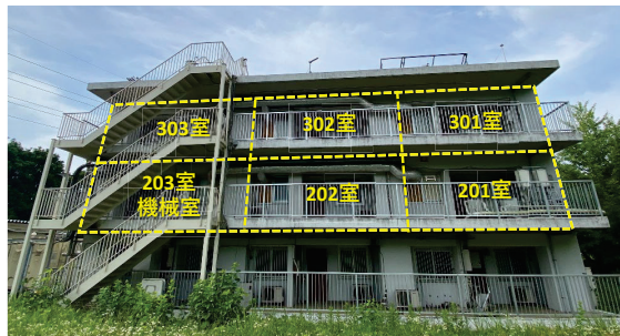
実験棟外観 (北面の共用廊下側)
