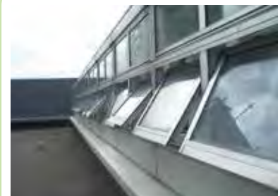
■ 図 3-4 外部への排気口
