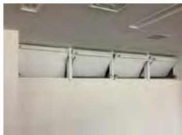
■ 図 3-3 吹き抜け排気口
